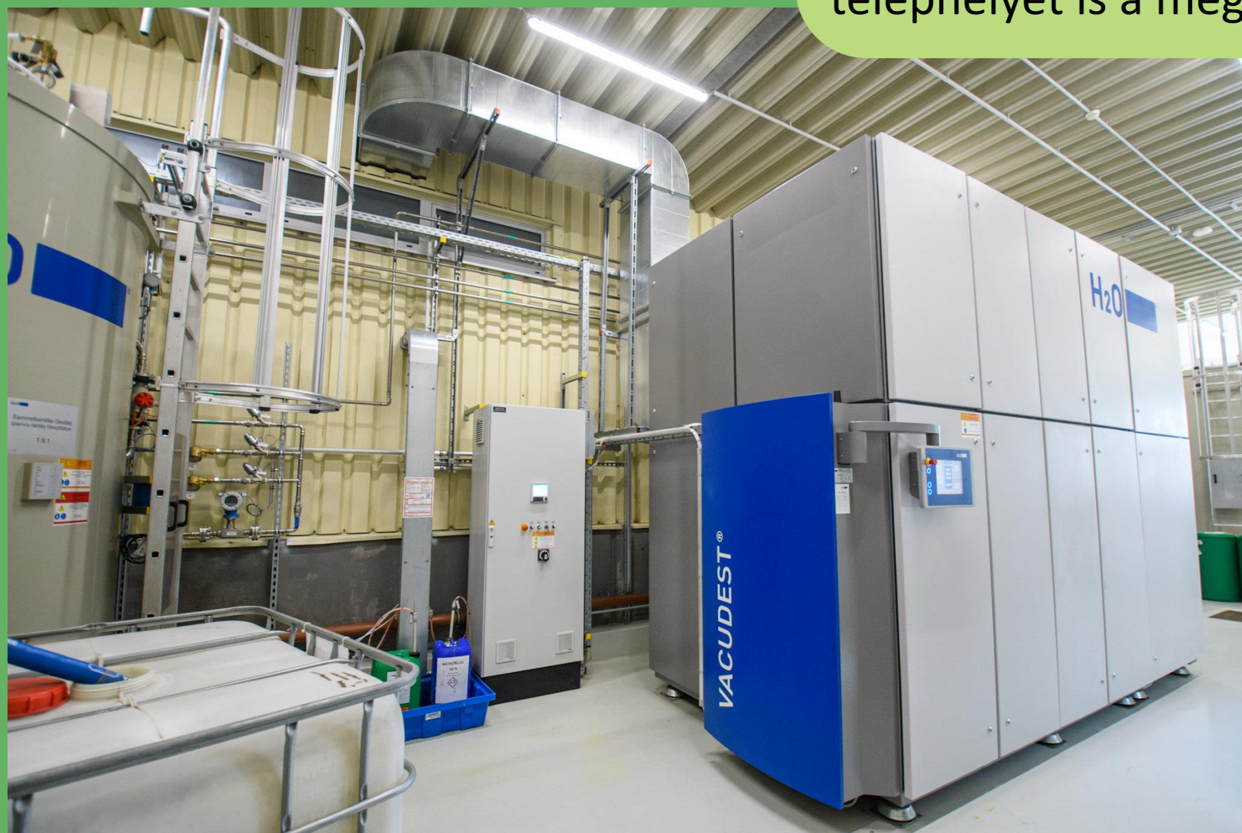
2. ábra: H 2 O VACUDEST vákuumdesztilláló berendezés az FAG Magyarország Ipari Kft. -nél
